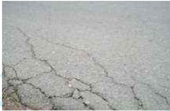
Gambar 2. 7 Retak Pinggir
