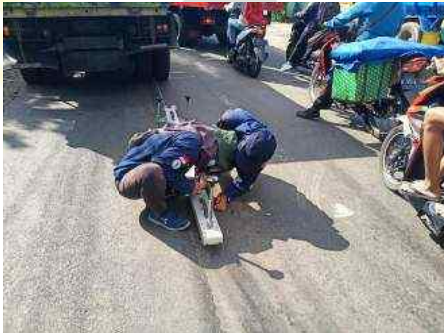
Foto Kegiatan Setting Alat Benkelman Beam
