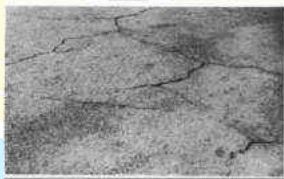
Gambar 2. 5 Retak Kotak-kotak
