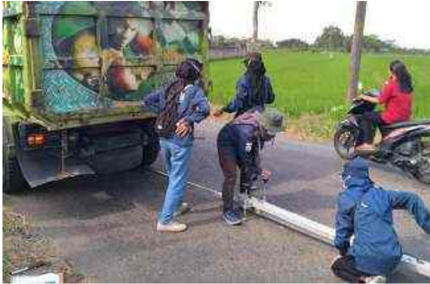
Foto Pelaksanaan Pengambilan Data Lendutan Jalan
