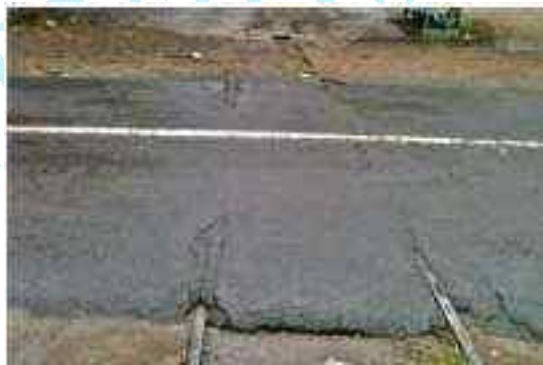
Gambar 2. 12 Rusak Perpotongan Rel
