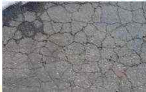
Gambar 2. 3 Retak Kulit Buaya
