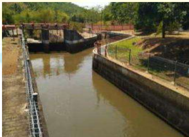
Gambar 2.6 Saluran buang Sub Unit PLTA Jelok
